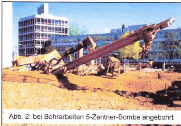
Abb. 2: bei Bohrarbeiten 5-Zentner-Bombe angebohrt
